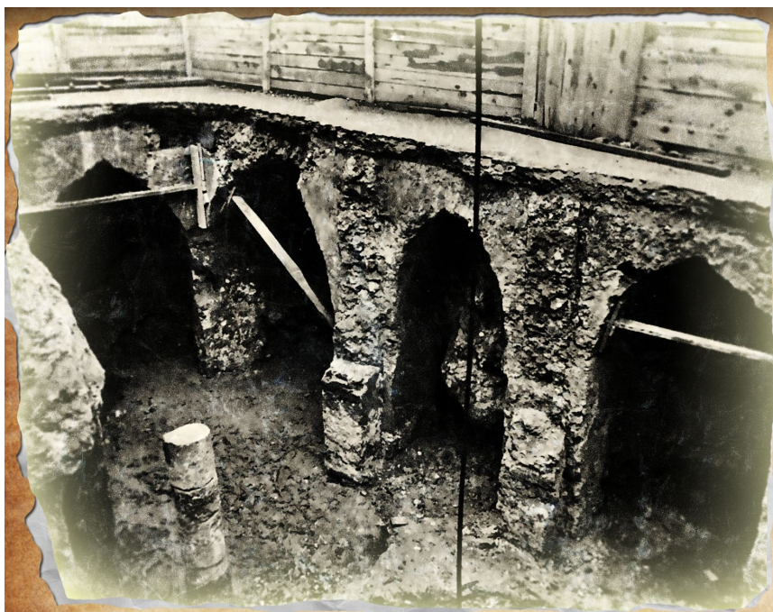
Udgravningen 1939 - billede fra hallen.
